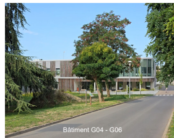
Bâtiment G04 - G06
